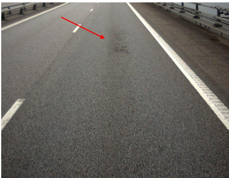
Figur 10 Bild på område med stensläpp mellan hjulspåren.
