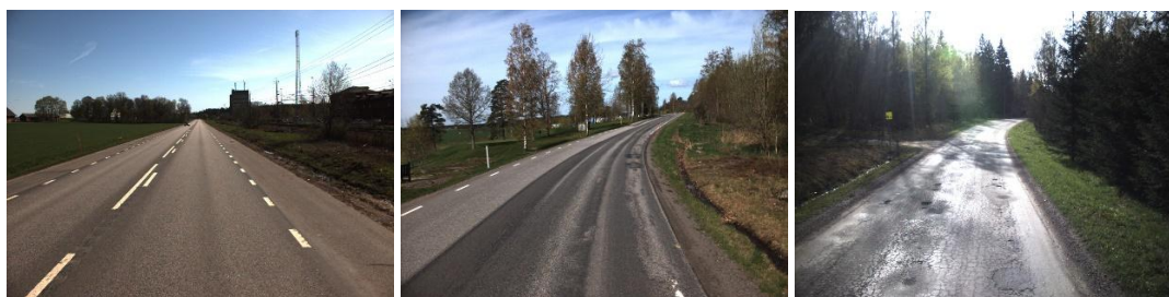
Figur 15 Tre sträckor med beräknat Underhållsindex, från vänster UI 0,00 (inget behov), 3,55 (måttligt behov) och 8,79 (akut behov).
